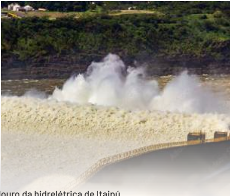
Vertedouro da hidrelétrica de Itaipú.
