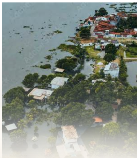
Alagamento beira rio.
