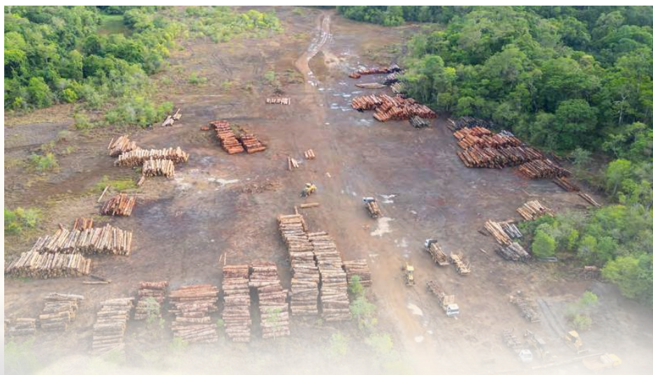
Canteiro de desmatamento.
