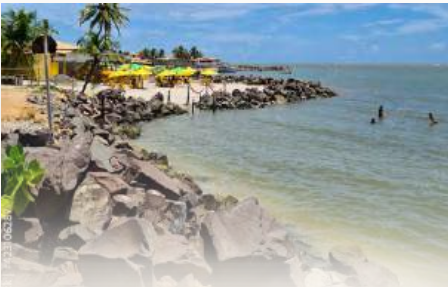
Pedras para conter a erosão.
